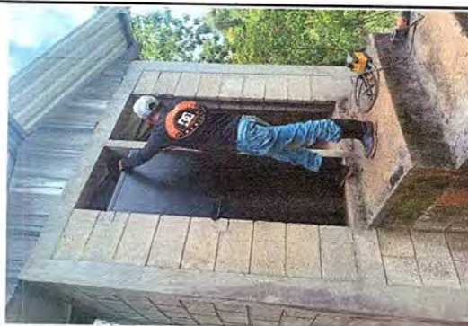
Foto 2: Puertas de baño, reparadas y pintadas.
