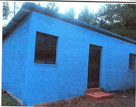
Foto1: Cocina actual con entechado, pintura y pared.
